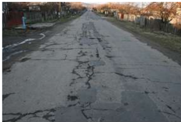
Situația existentă pe DJ 662
